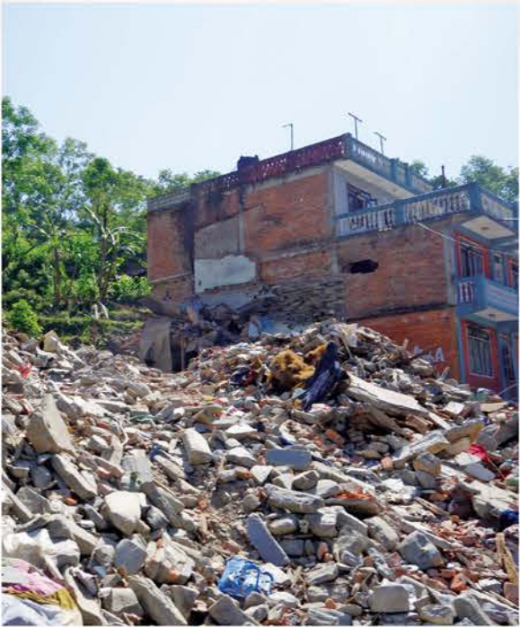
強い住宅を徹底させる行政の力が住民を守ることにつながる。不十分ではあっても鉄筋や梁があることで倒壊せず残った建物(奥)と、瓦礫と化した庶民建築(手前) (ネパール2015年5月)
