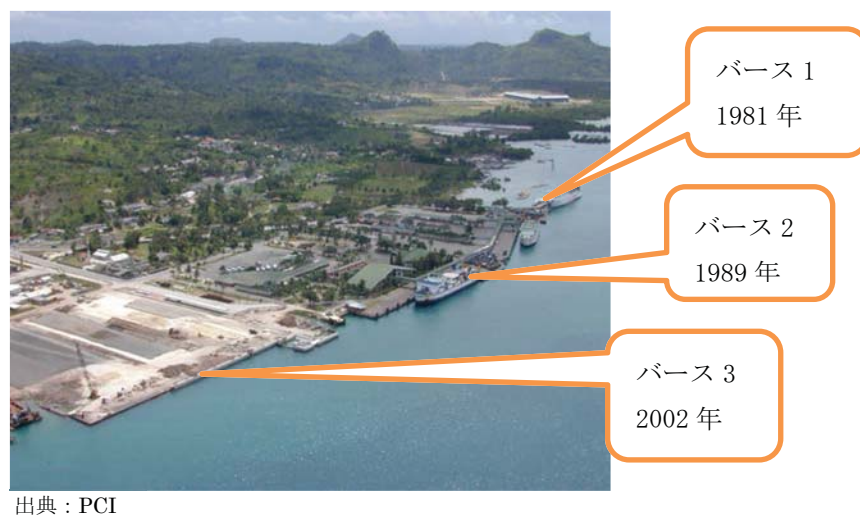
バカウニ フェリーターミナル全景 No. 3 バース（フェーズ 3）建設工事進行中（2001 年当時）
