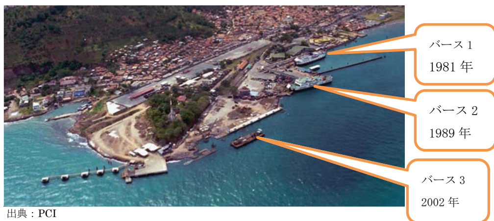
メラク フェリーターミナル全景 No. 3 バース（フェーズ 3）建設工事進行中（2001 年当時）
