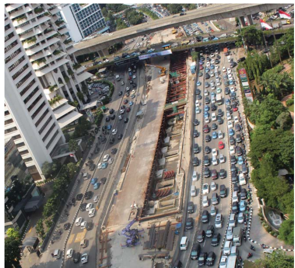
開削工法で施工中の ブンドゥンガン駅
