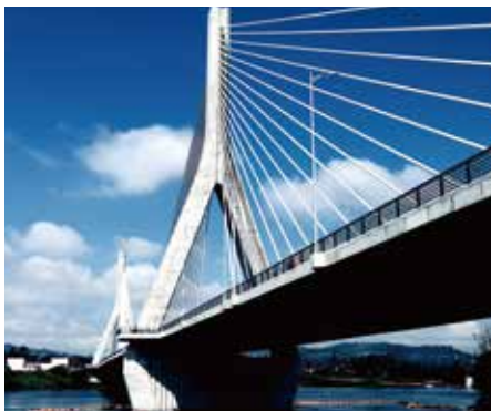
ナイル架橋建設事業（ウガンダ） 写真：株式会社銭高組
